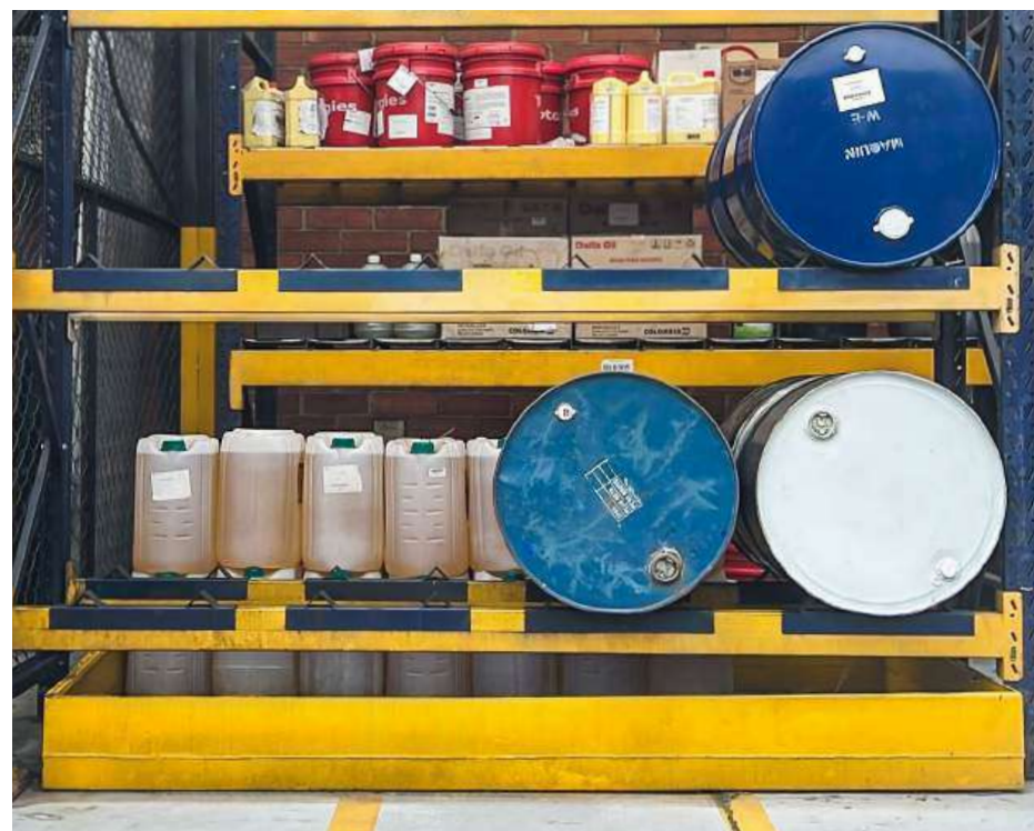
Dique de contención de derrames.
